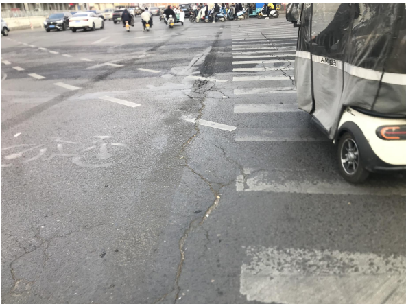
图 4-14 块状裂缝
