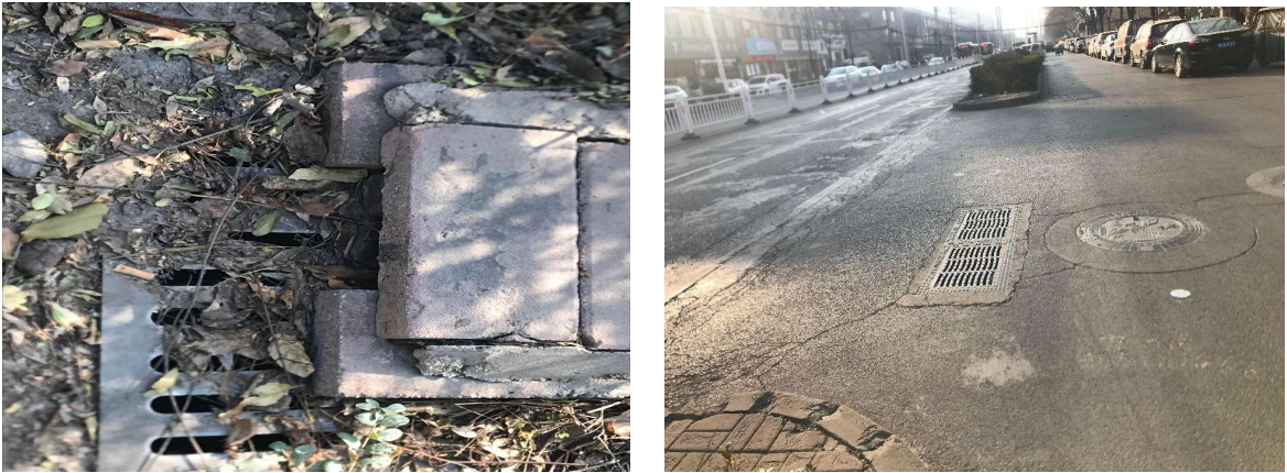
图 3-9 现状雨水口和雨水检查井
