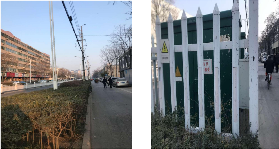
图 3-14 现状侧分带内高压线杆和箱变
