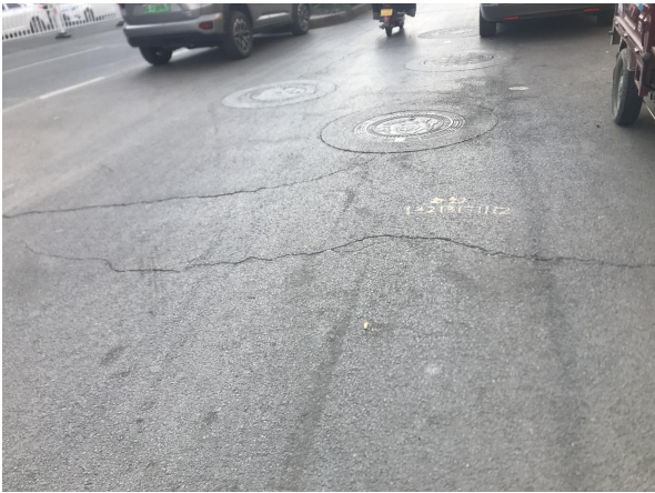
图 4-10 横向裂缝
