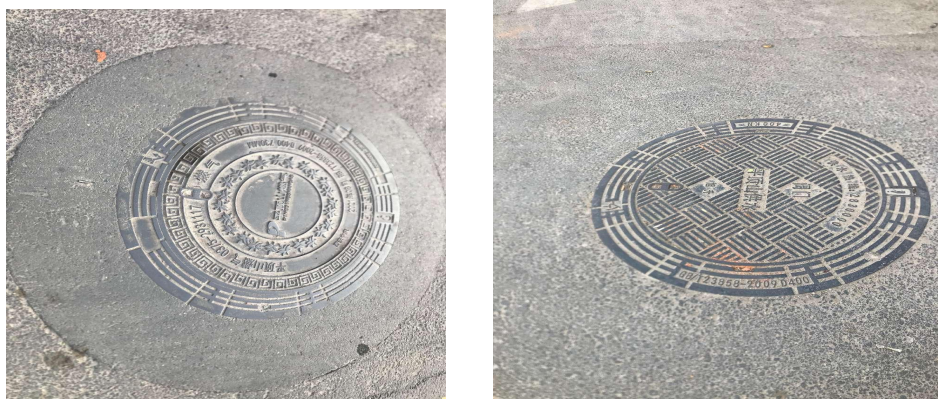
图 3-11 现状给水检查井和燃气检查井
