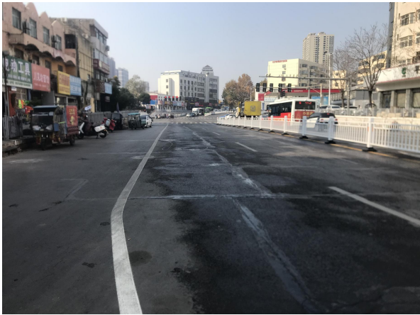
图 4-11 纵向裂缝
