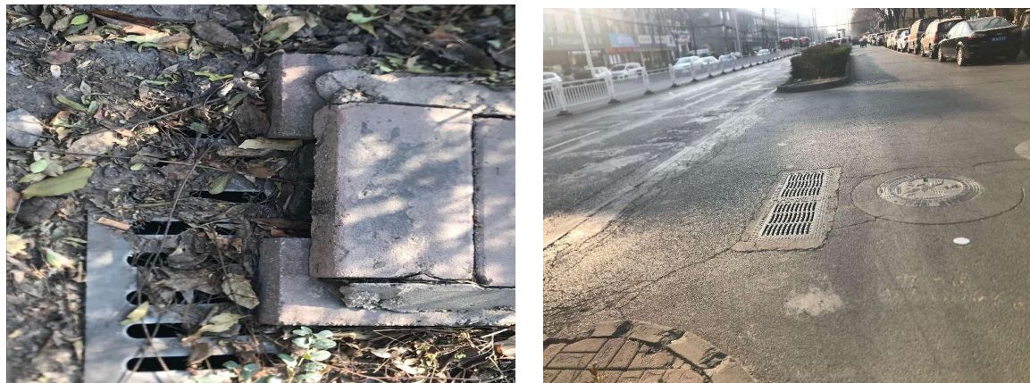
图 2-1 现状雨水口和雨水检查井
