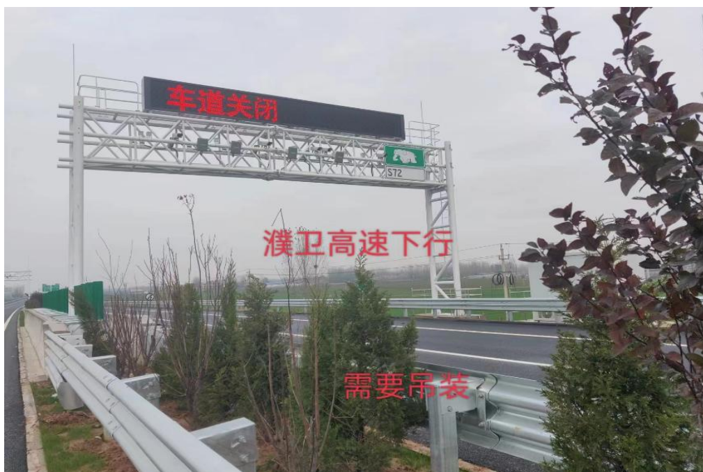
图 1. K38 处现场情况
