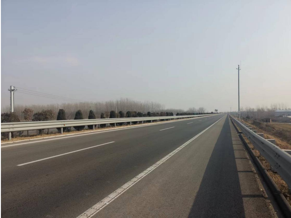
图 4. K25 处现场情况
