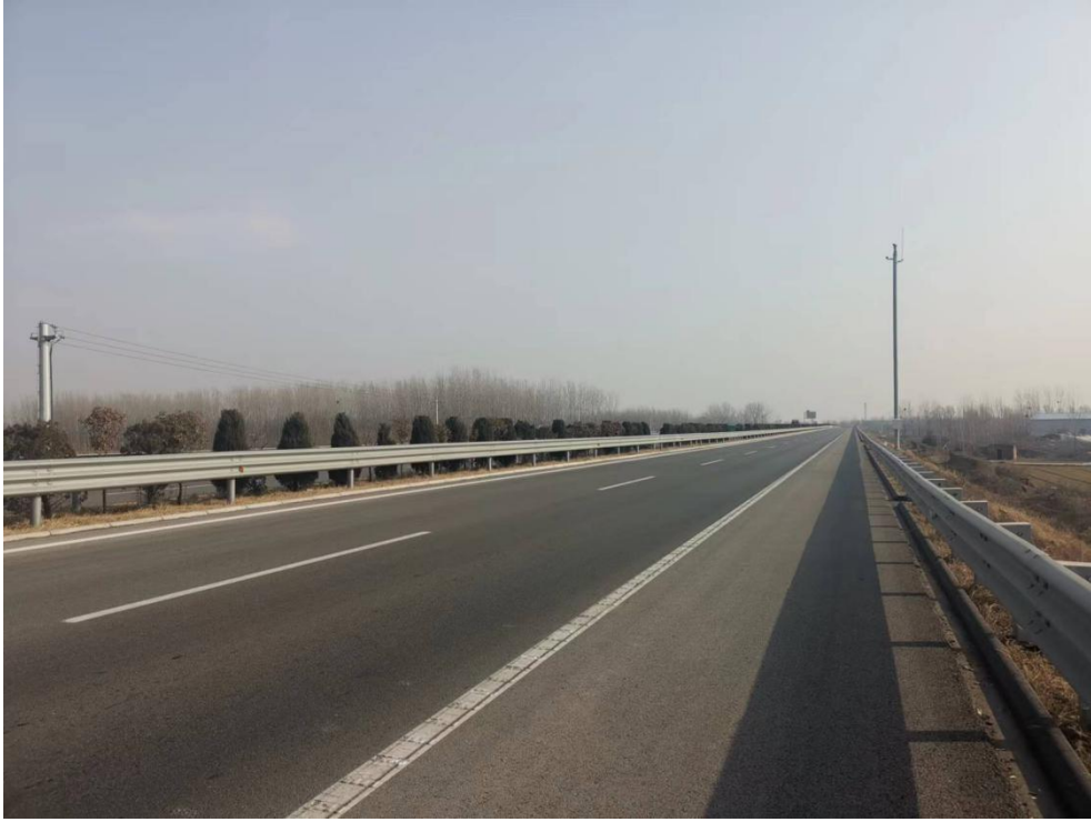
图 4. K25 处现场情况
