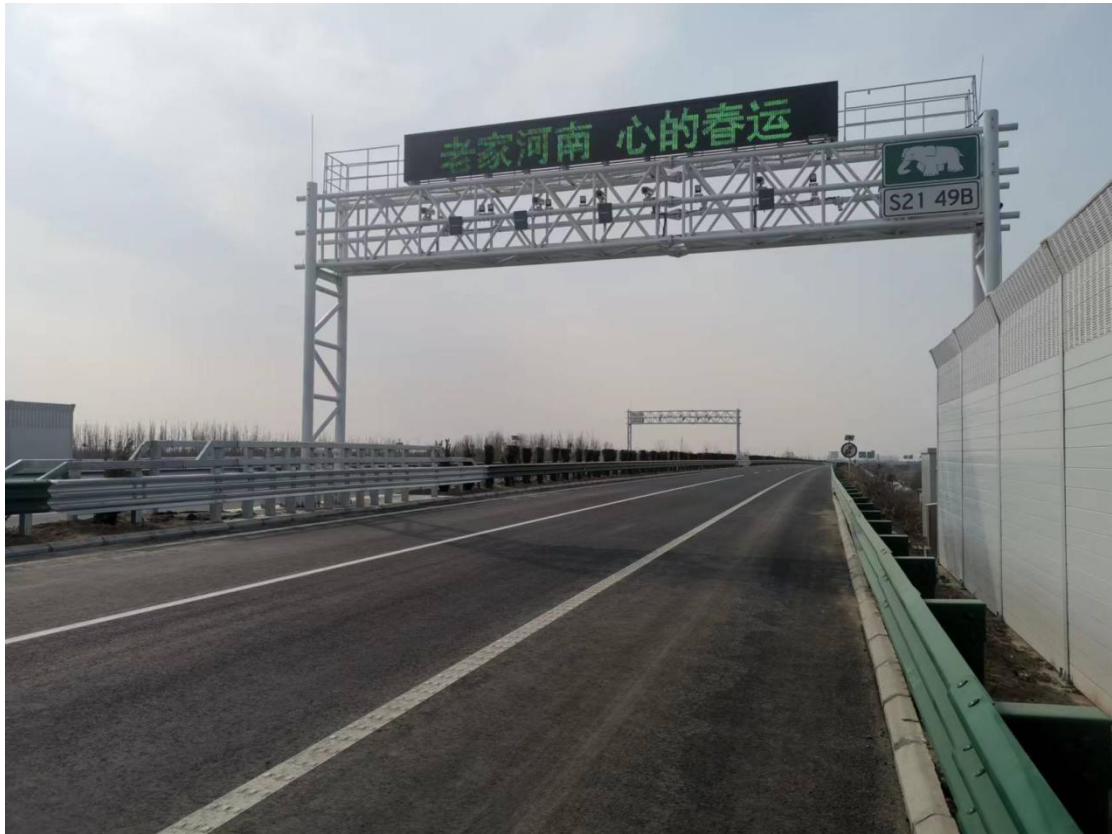
图 2. K60 处现场情况
